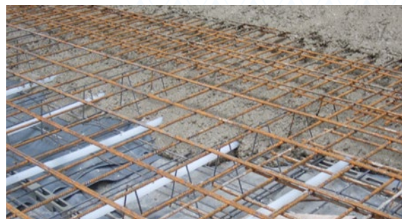
Beispiel: Rohrbefestigung auf der unteren Bewehrung
